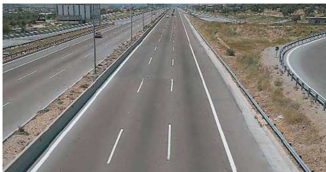
Σχ. 7.5α Αυτοκινητόδρομος.
